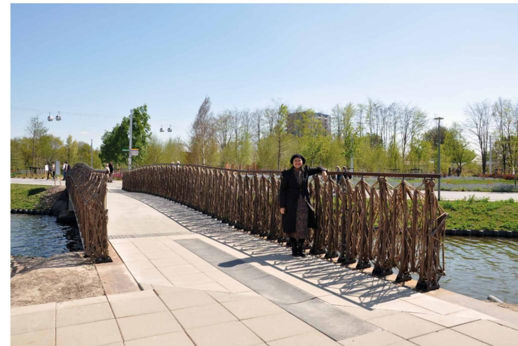
Die Brücke besteht aus mit Flachsfasern umhüllten Polyurethanblöcken, das Gelände aus nach einer neuen Methode gewickelten Flachsbündeln.
